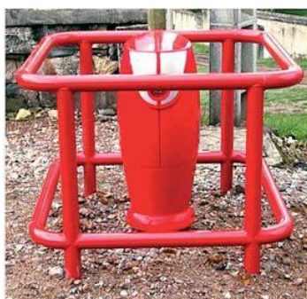
Exemple de poteau incendie doté d'un système de protection
