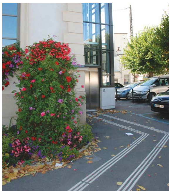
Cheminement tactile guidant vers l'ascenseur (Coulommiers)
