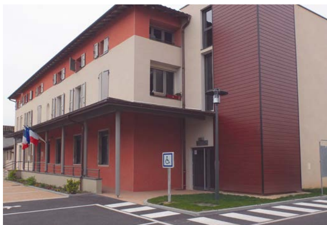
Matérialisation au sol du cheminement d'accès à la mairie avec bordure latérale assurant un guidage tactile (Foissiat).
