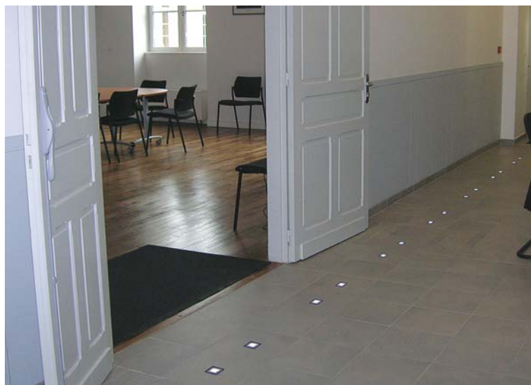
Implantation d'un guidage au sol lumineux dans les couloirs (Villebois-Lavalette)
