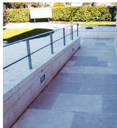
Aménagement d'une rampe d'accès à la mairie en pierre de pays favorisant l'intégration architecturale. Cette rampe est équipée de pavés lumineux facilitant son utilisation et son repérage de nuit (Villebois-Lavalette)
