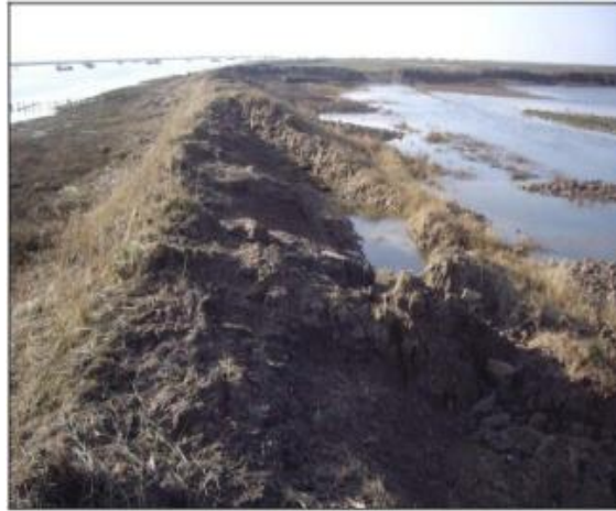
Figure 22 : Digue des marais vendéens (photo Verger)
