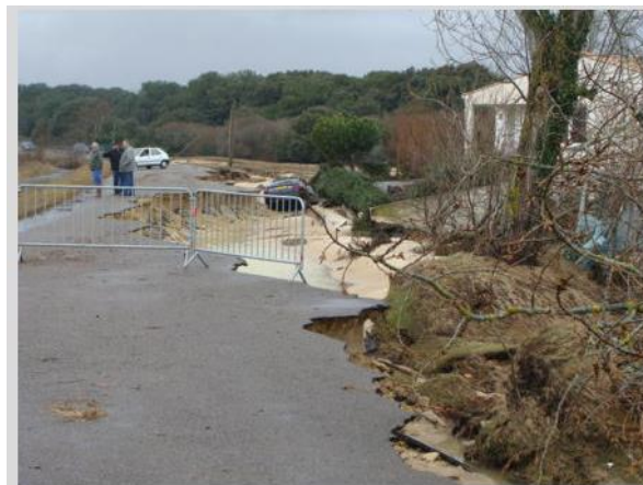
Figure 53 : route-digue au port du Collet après Xynthia (Photo Syndicat).
