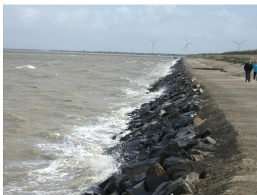
Figure 5 : digue du Dain (photo ISL)
