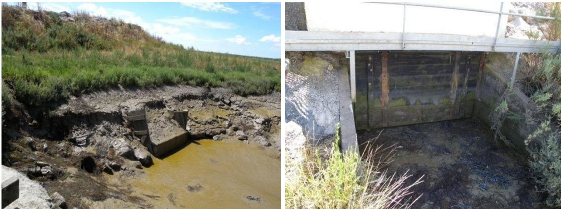
Figure 38 : Ouvrages traversants présents sur la digue de la Parisienne (source : EDD)
