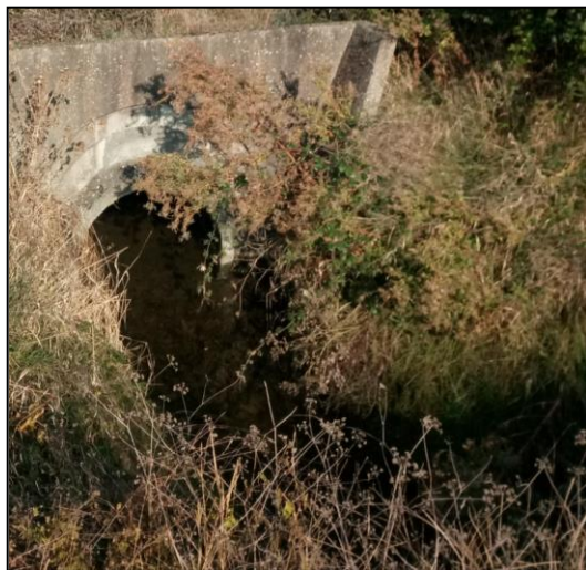
Fossé au nord-est du projet avec arrivée d'eau du lotissement en amont
